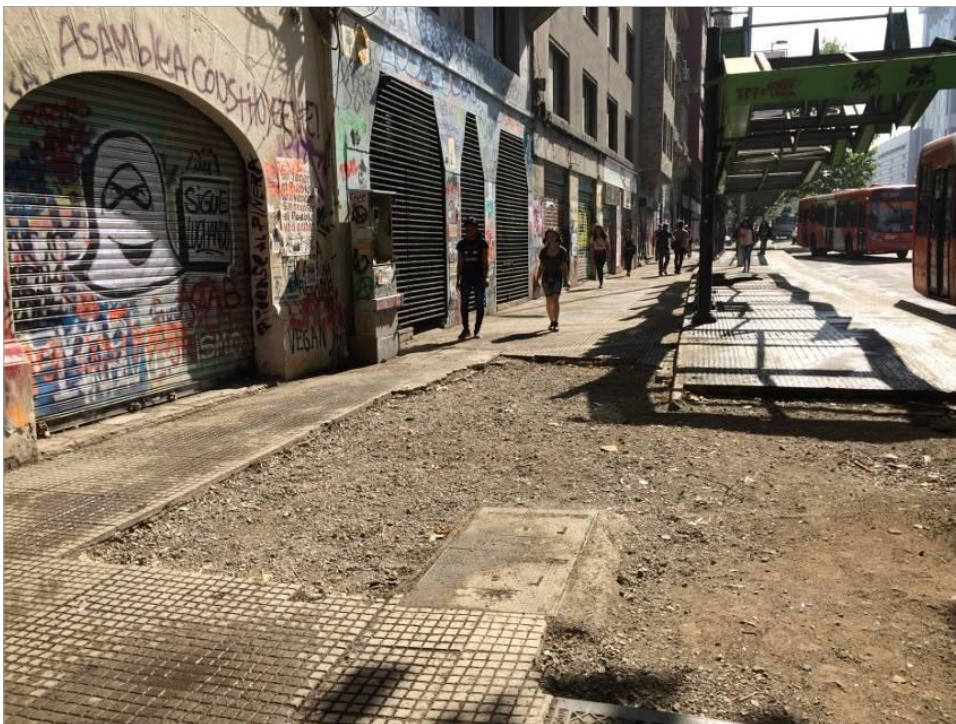
Foto 3.8 – Destrucción de aceras y paraderos. Entorno plaza Baquedano.
