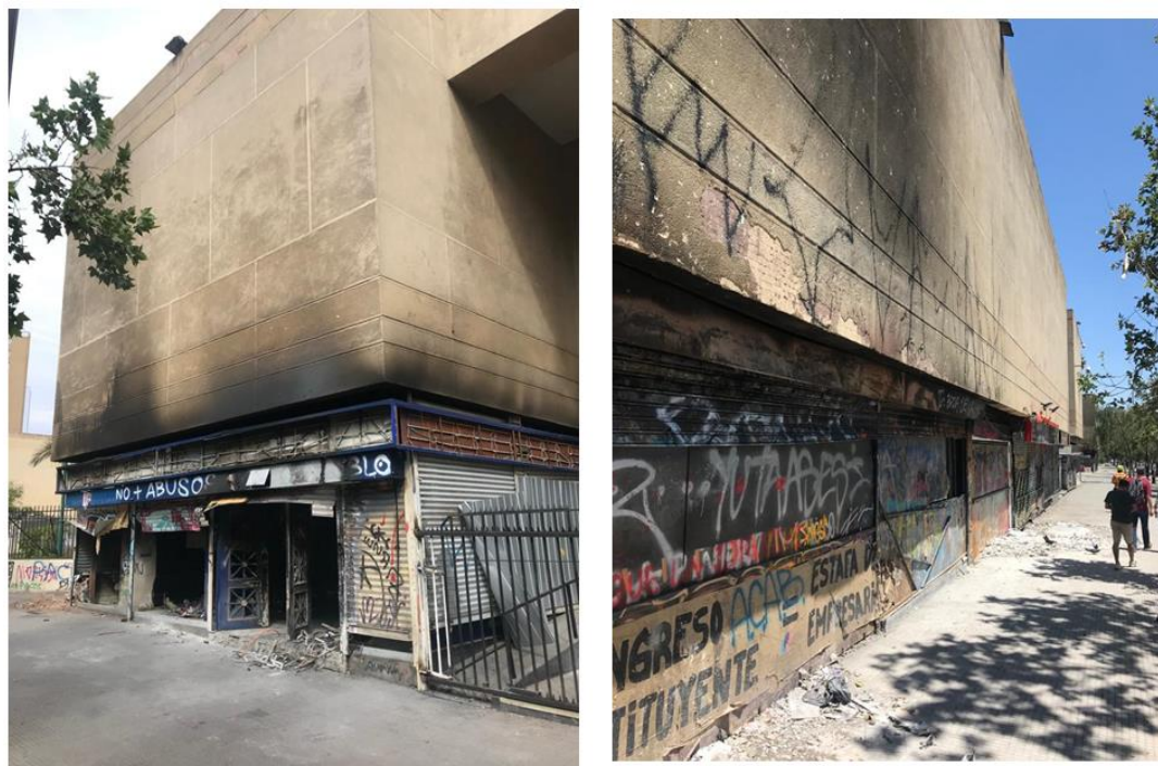
Foto 3.2 – Galerías comerciales destruidas. Hotel Crowne Plaza
