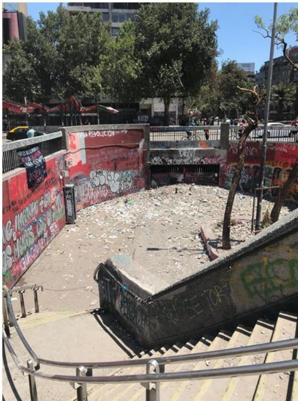
Foto 3.1 – Acceso y plaza destruida estación Metro Baquedano.
