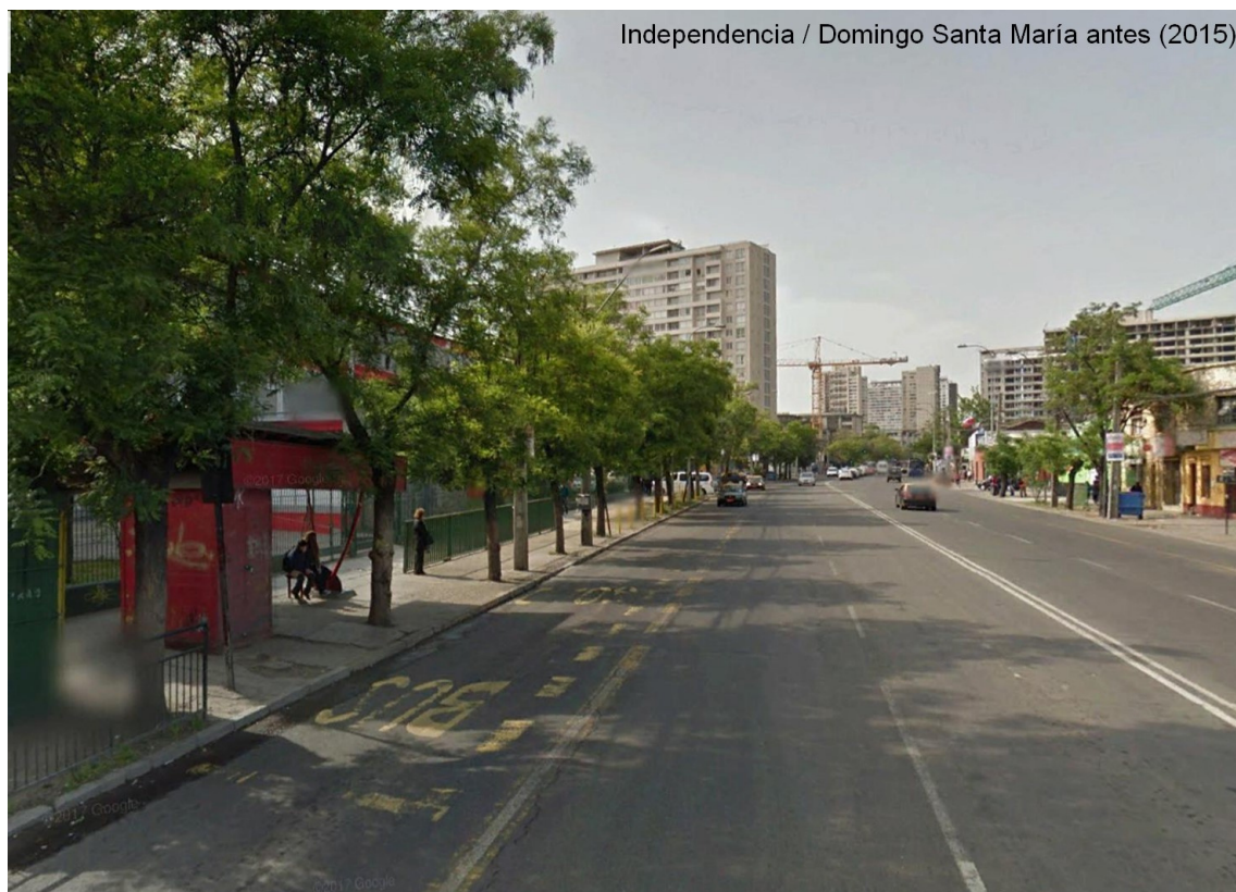
Figura 3.8– Impactos BRT Avenida Independencia / Domingo Santa María.
